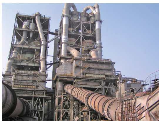
● 汚染土壌の掘削除去とセメント原料への資源化
