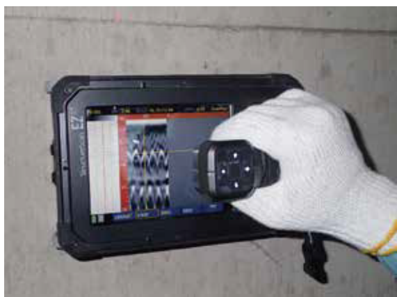
● 鉄筋探査状況
